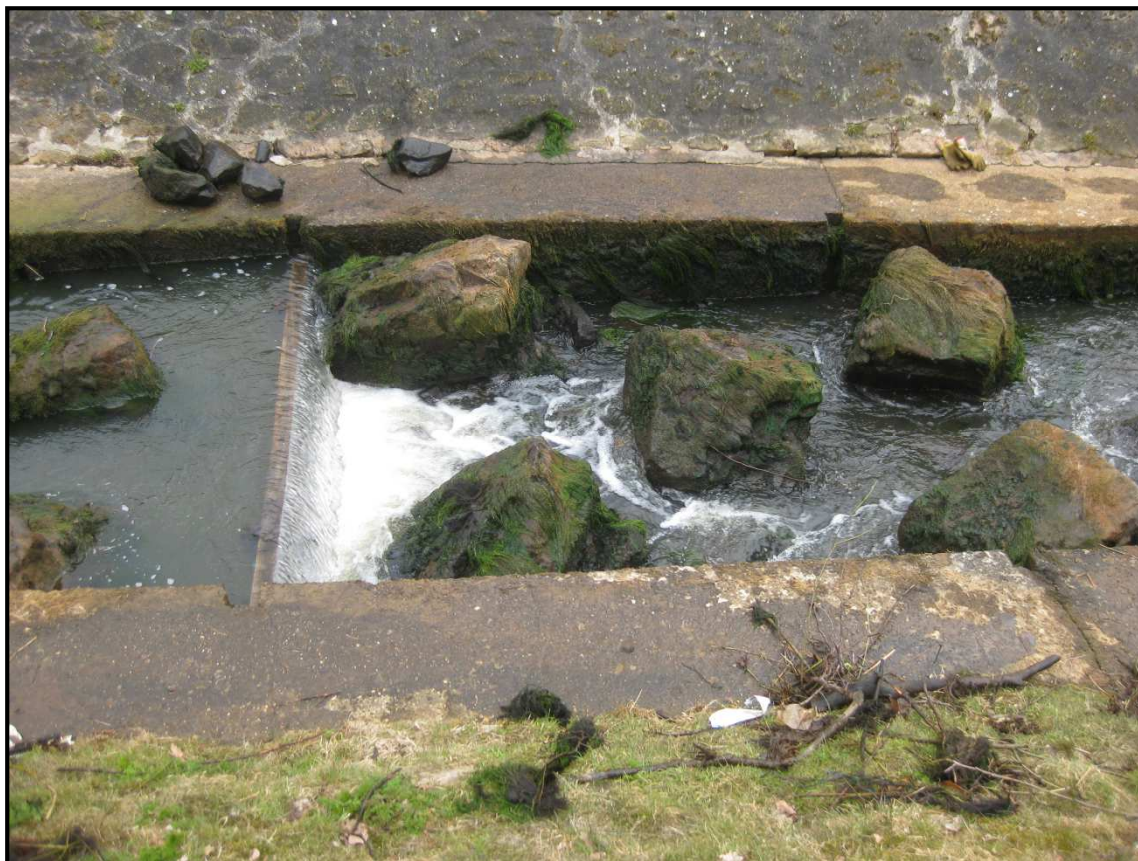
Abbildung 5: Blick auf die unterwasserseitige Absperrung vor Installation der Aalleiter (Quelle: Landesfischereiverband Weser-Ems).
