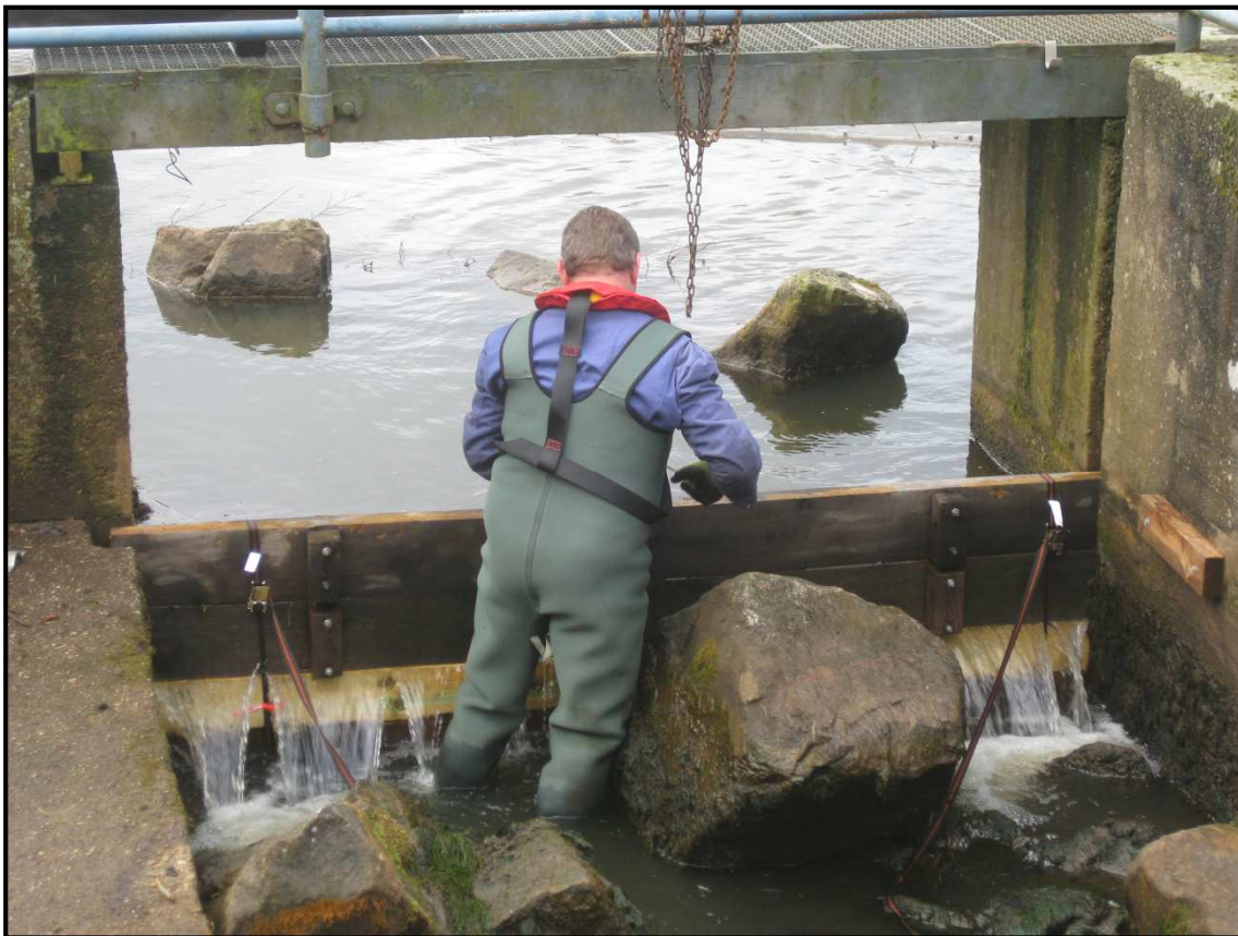
Abbildung 4: Errichtung der oberseitigen Absperrung des Fischweges (Quelle: Landesfischereiverband Weser-Ems).
