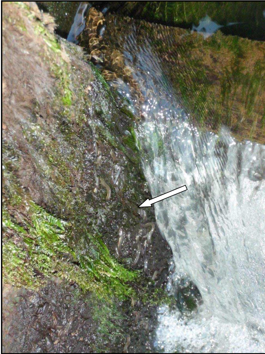
Abbildung 10: Glasaale (Pfeil) erklettern die Seitenwand der Fischaufstiegsanlage oberhalb der Wasseroberfläche und überwinden den unterwasserseitigen Dammbalkenverschluss, der die Absperrung auf Höhe der Aalleiter bildet (Quelle: Landesfischereiverband Weser-Ems).
