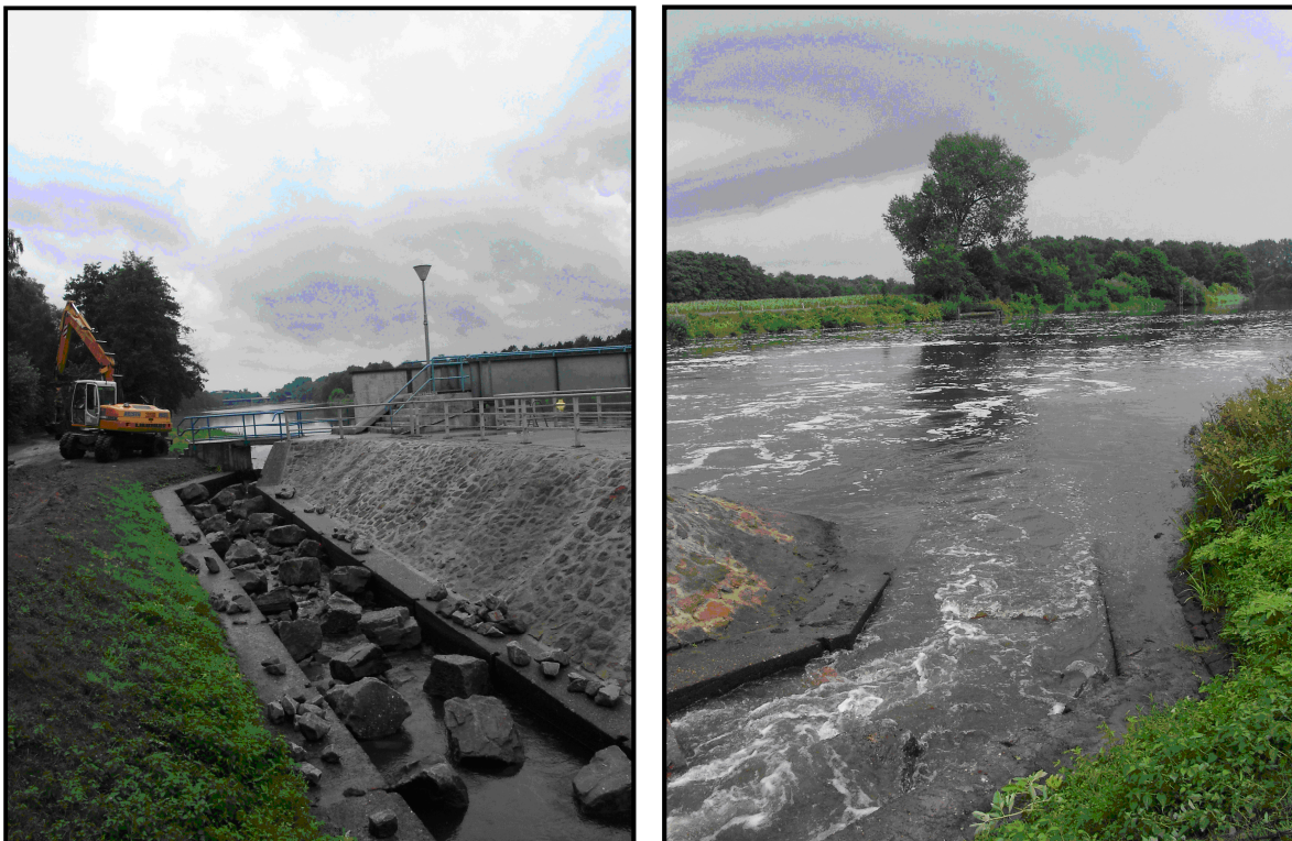
Abbildung 3: Die Fischaufstiegsanlage (FAA) am Wehr Bollingerfähr. Links: FAA während der Ertüchtigung. Rechts: Unterwasserseitiger Anschluss der FAA Bollingerfähr bei mittlerem Emsabfluss (Quelle: Landesfischereiverband Weser-Ems).
