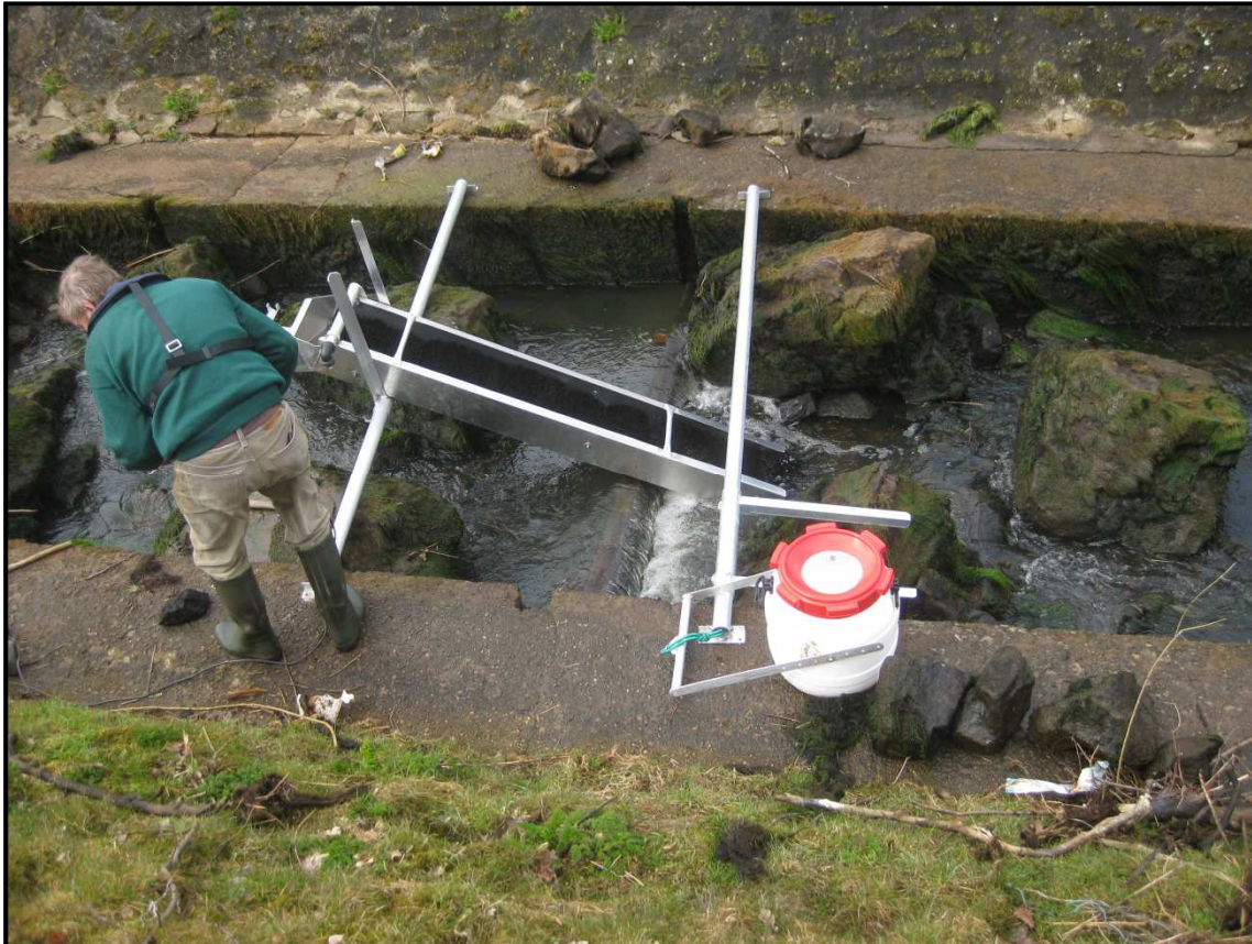
Abbildung 7: Positionierung der Aalleiter in der Fischaufstiegsanlage (Quelle: Landesfischereiverband Weser-Ems).
