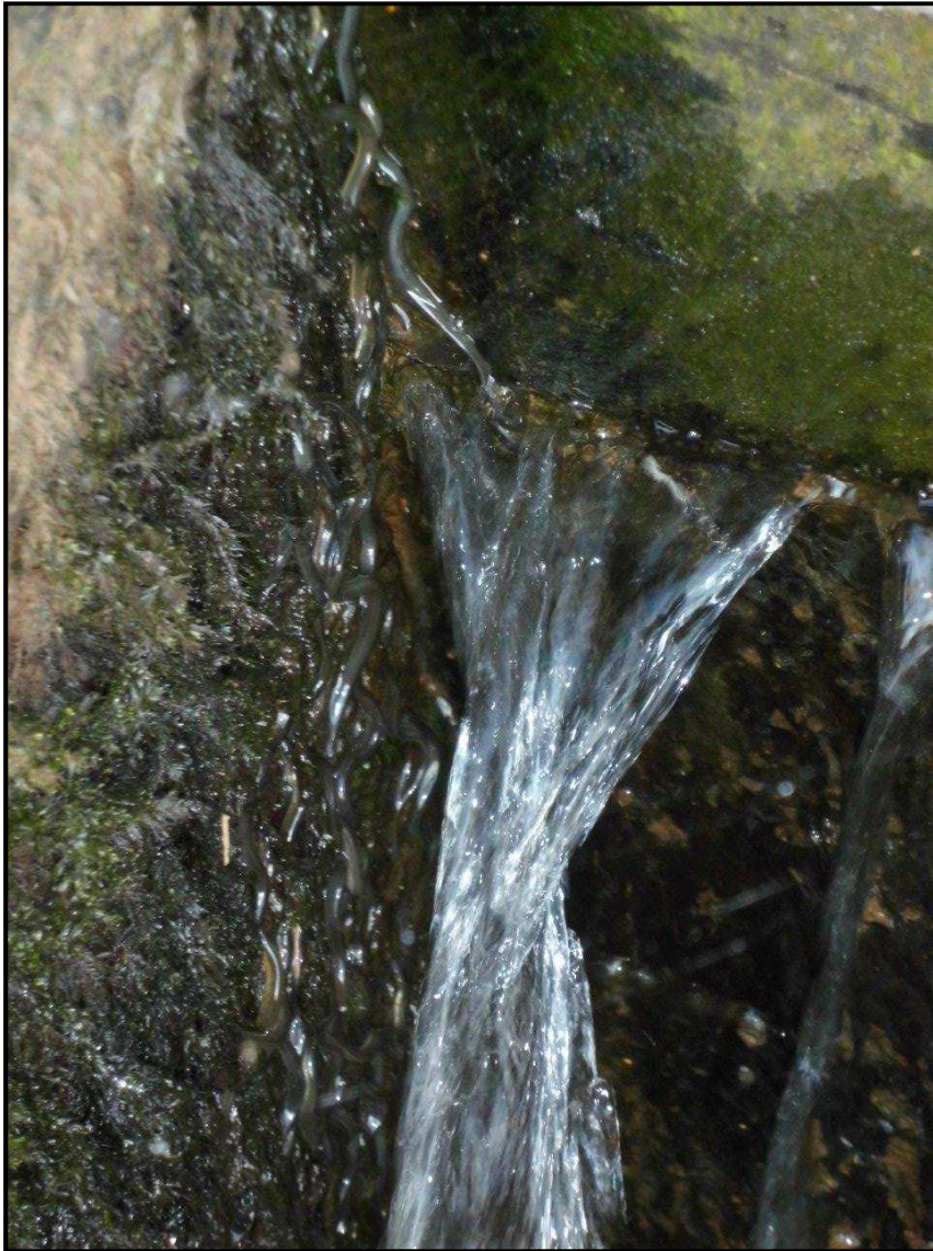
Abbildung 11: Glasaale erklettern die Seitenwand der Fischaufstiegsanlage beim Versuch, den oberwasserseitigen Dammbalkenverschluss zu überwinden. Zuvor haben sie bereits die Aalleiter umgangen (Abbildung 10) (Quelle: Landesfischereiverband Weser-Ems).
