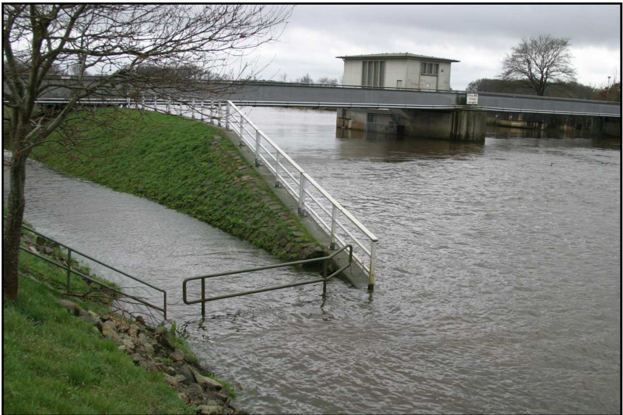
Abbildung 15: Wehr Herbrum bei Tidehochwasser vom Unterwasser aus. Die Fischaufstiegsanlage (vorne im Bild) mit der daneben verlaufenden Aalfangrinne ist ebenso wie das Wehr im Hintergrund überflutet. Das Wehr wird heutzutage deutlich häufiger bei auflaufender Tide überströmt, so dass sich der Standort nicht mehr im selben Maße für den quantitativen Glasaalfang eignet wie früher (Quelle: LAVES).
